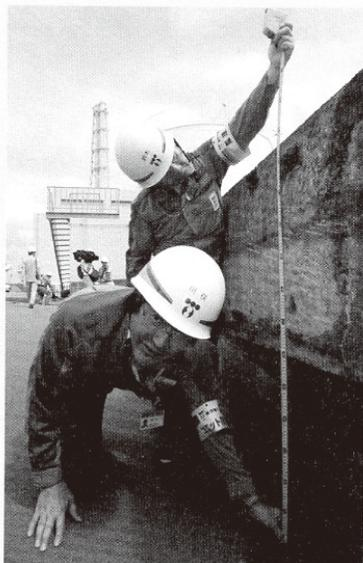
▲地震によって原発1号機(左奥)の軽油タンク付近にできた1メートル25センチもの段差(2007/7/21)
